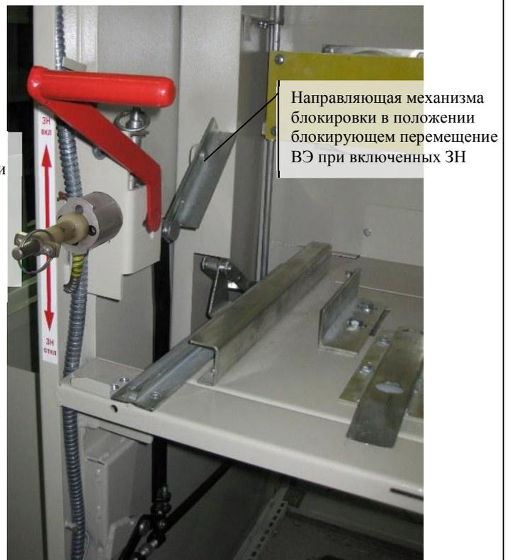
Рис.10. Блокировки ЗН и ВЭ. ЗН включен.
