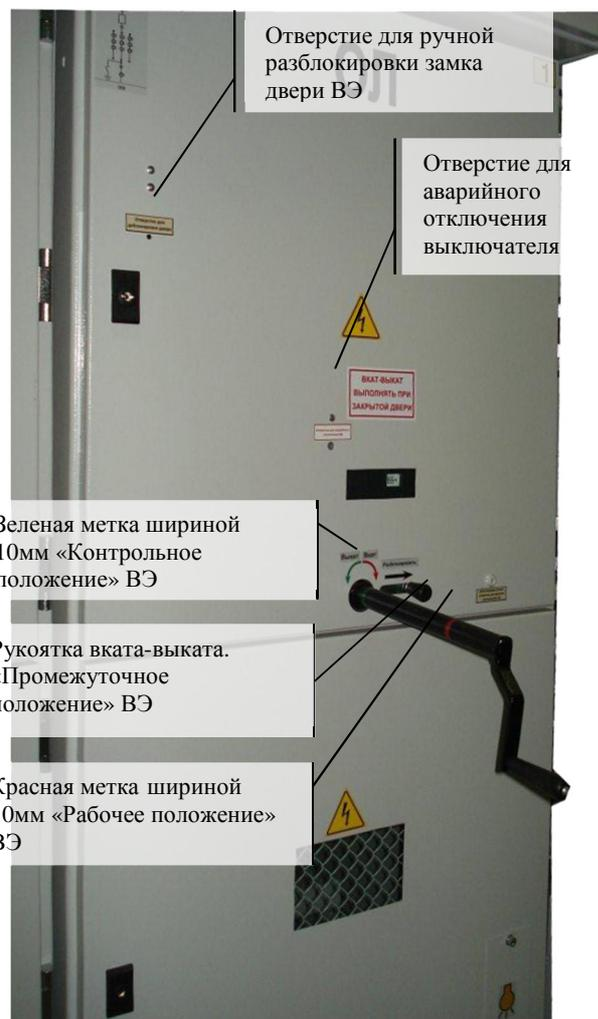
Рис.3. Отсек ВЭ.
