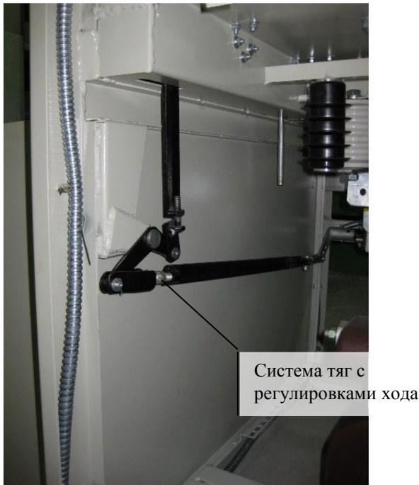
Рис. 11. Тяги ЗН в отсеке КП.
