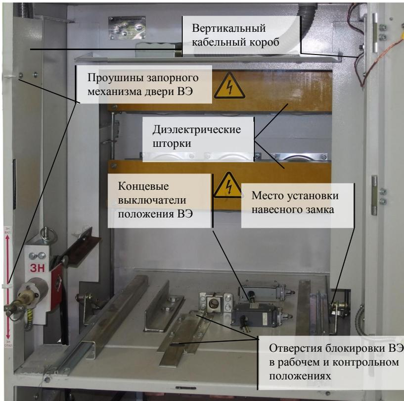
Рис. 8. Отсек ВЭ.
