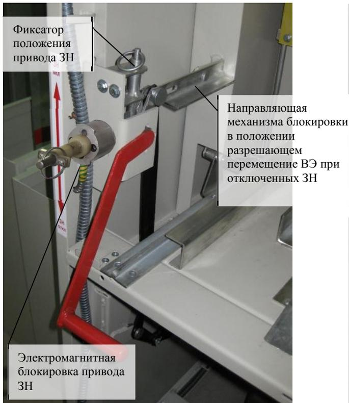
Рис.9. Блокировки ЗН и ВЭ. ЗН отключен.
