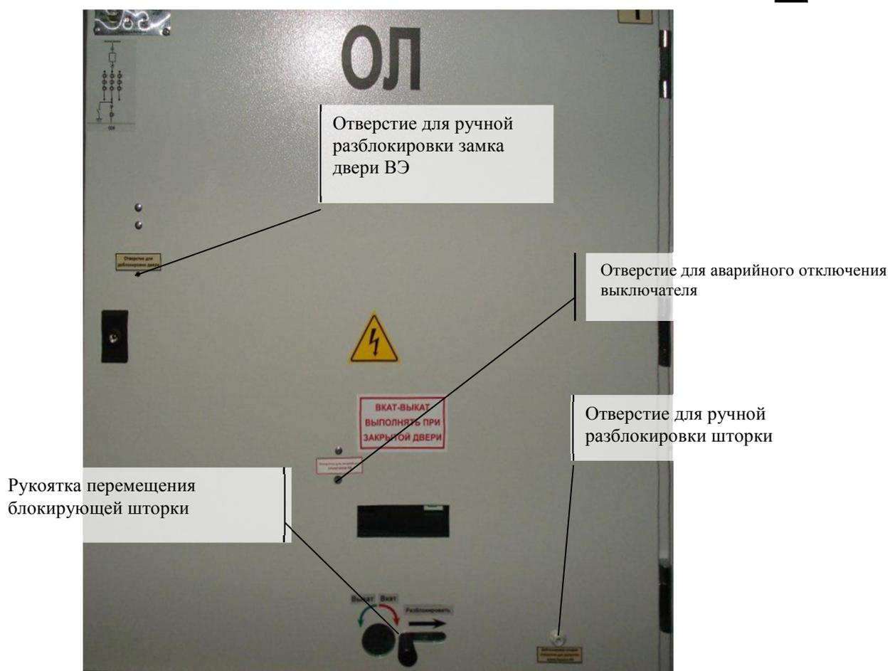
Рис.6. Дверь отсека ВЭ, вид снаружи.
