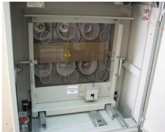
Рис. 28. Фазировочная тележка в отсеке ВЭ.
