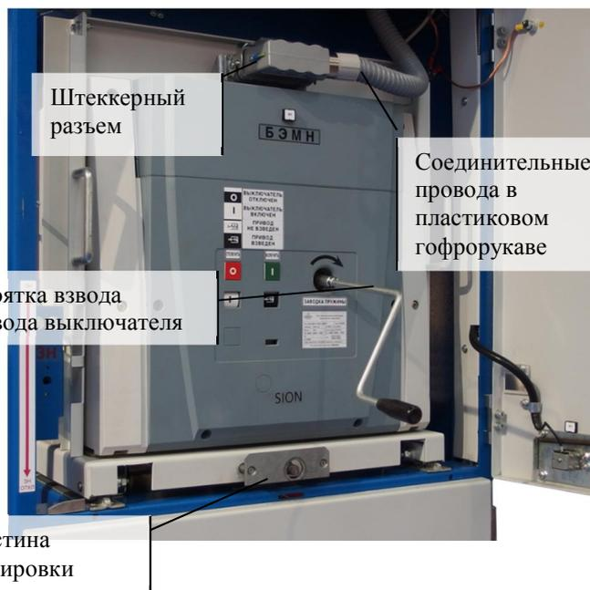
Рис.5. Выкатной элемент с рукояткой взвода
