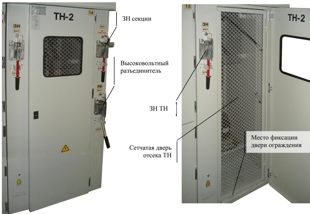
Рис. 14. Расположение рукояток управления ЗН и РВ.
