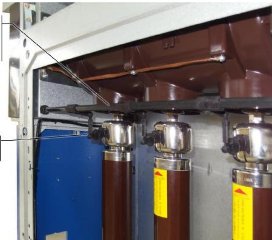
Индикатор срабатывания предохранителя
